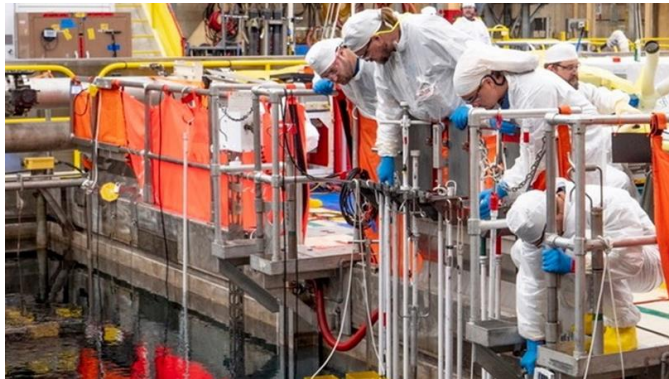
Néhány bevezető pálca behelyezése a Hatch atomerőmű 1. blokki pihentető medencéjébe (Fotó: Southern Nuclear [2])
